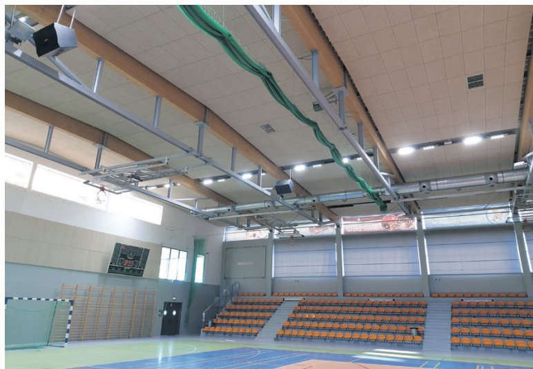
Modernizacja oświetlenia boiska wielofunkcyjnego hali sportowej
