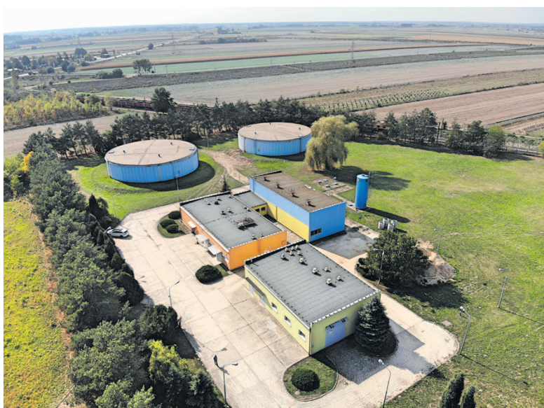
Zakład Uzdadniania Wody – ul. Dobroszycka
