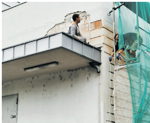
Remont elewacji budynku Miejskiego Ośrodka Kultury i Sztuki w Oleśnicy
