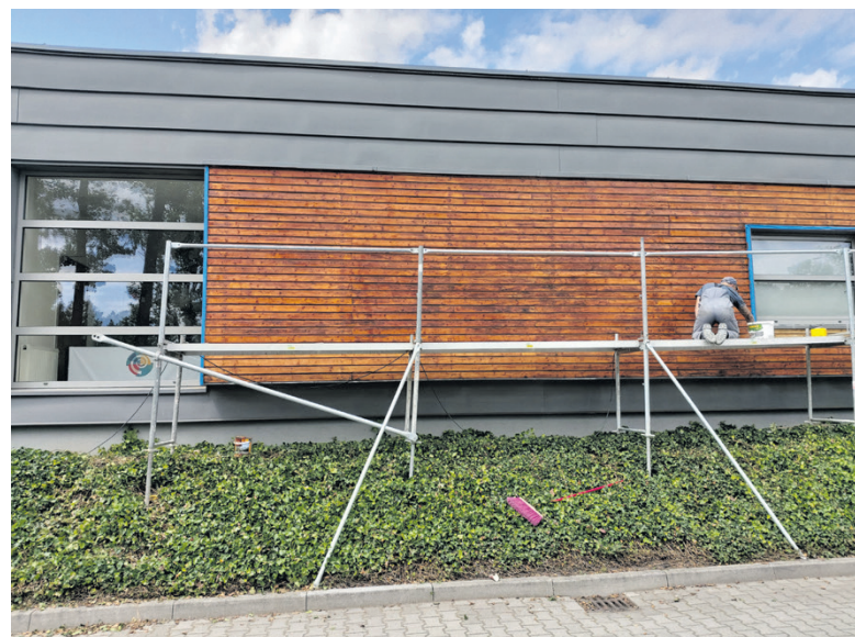
Remont elewacji drewnianej budynku
