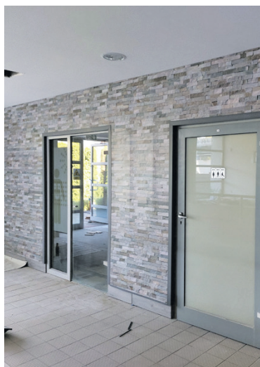
Wymiana drzwi w pomieszczeniach basenu krytego
