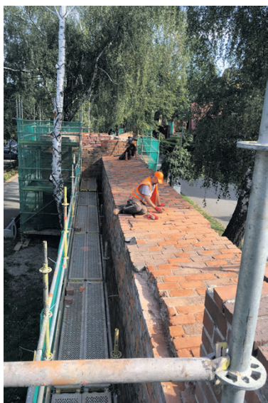
Remont zabytkowych murów obronnych
