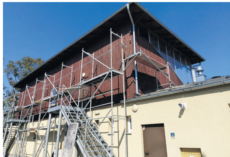
Naprawa poszycia dachowego nad główną trybuną stadionu miejskiego
