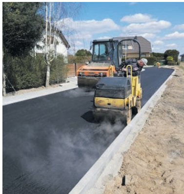
Budowa ul. Pułaskiego
