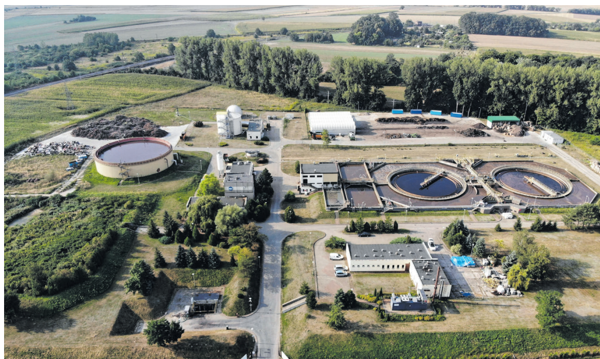
Nowoczesna oczyszczalnia ścieków komunalnych
