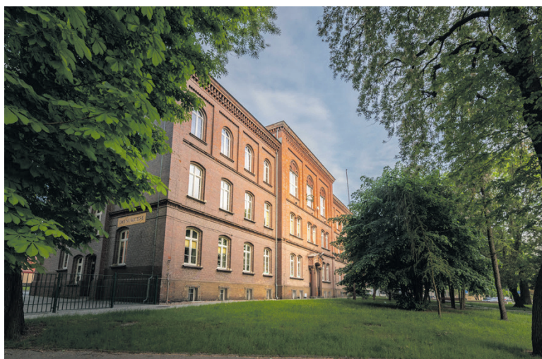
Termomodernizacja budynku Szkoły Podstawowej nr 1
