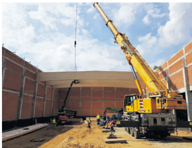
Zakładanie dźwigarów dachowych na nowej hali sportowej
