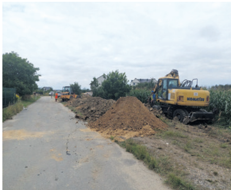
Ruszyły prace przy budowie drogi na ul. Europejskiej
