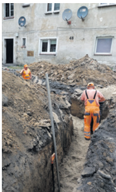
Układanie kanalizacji sanitarnej
