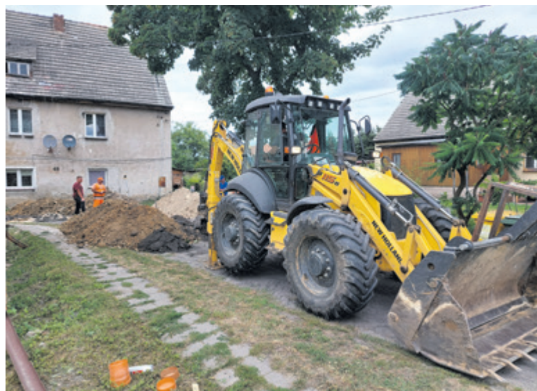
Zaawansowane prace ziemne na ul. Wiejskiej
