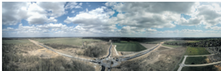
Zarys obwodnicy już widoczny
