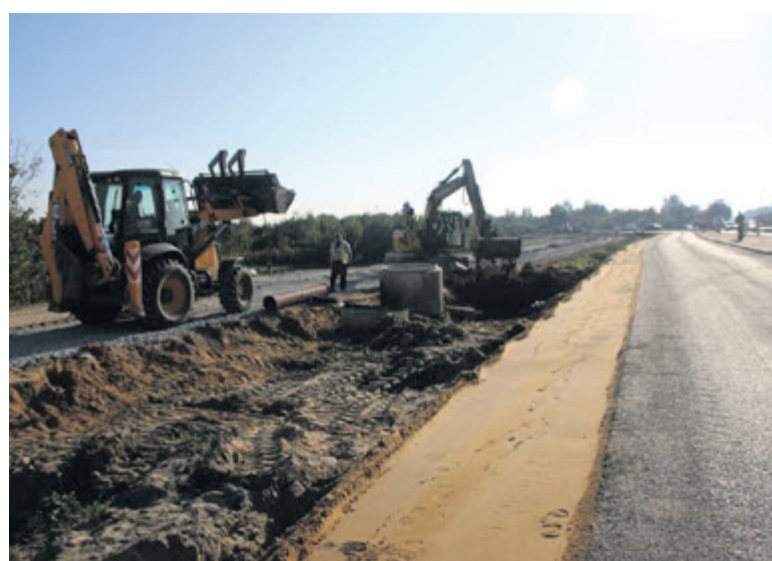
Prace przy budowie wschodniej obwodnicy Oleśnicy
