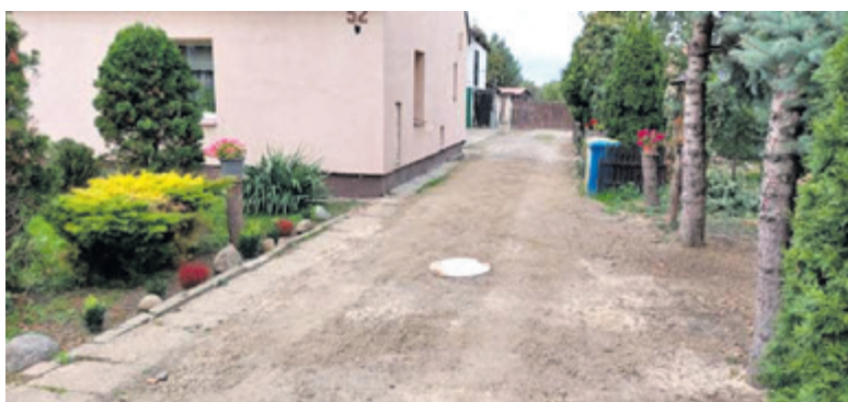
Cała ulica Wiejska z kanalizacją
