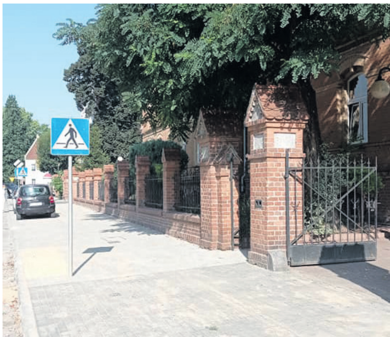
Wyremontowany chodnik na ul. Hallera
