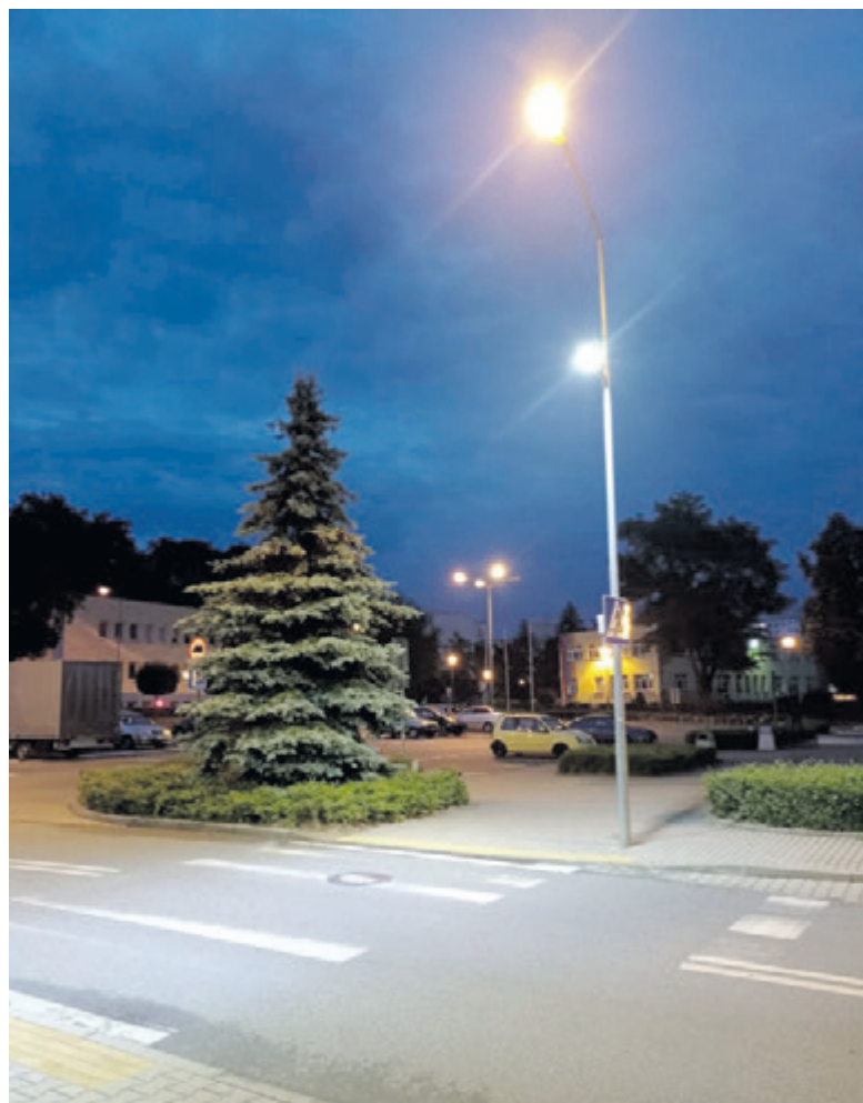
Doświetlone przejścia dla pieszych
