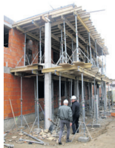
Budowa mieszkań socjalnych
