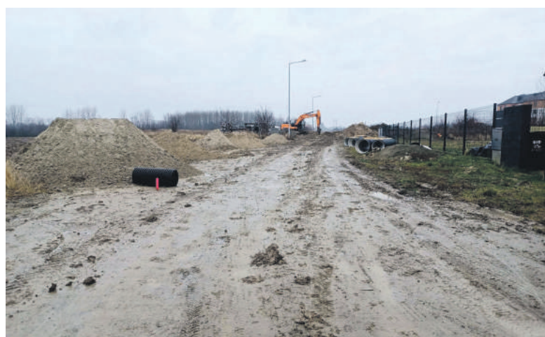
Prace przy ul. Belgijskiej potrwają dziesięć miesięcy
