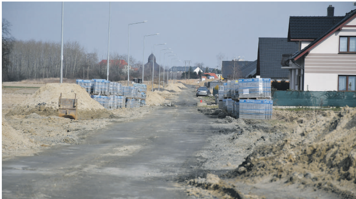
Na budowę dróg (na zdjęciu ul. Belgijska) oleśnicki samorząd pozyskał środki zewnętrzne z Polskiego Ładu
