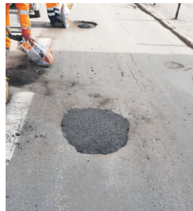
Wraz z wiosną ruszają remonty dróg zarządzanych przez SDM
