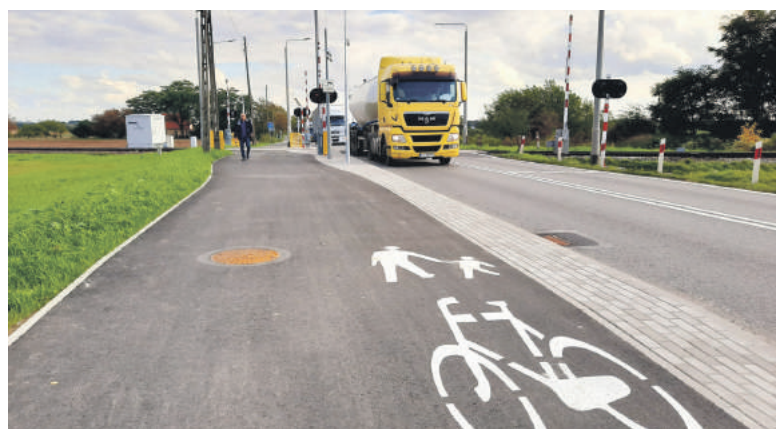
Przy ul. Krzywoustego powstała nowa ścieżka i przejście przez tory
