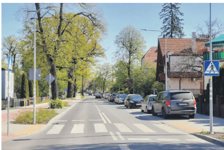
Nawierzchnia jezdni przy ul. Wały Jagiellońskie została poszerzona
