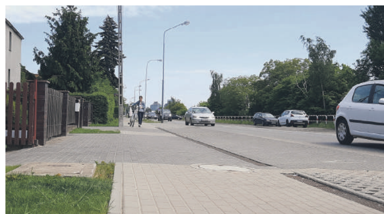
Wjazd na każdą posesję został przebudowany
