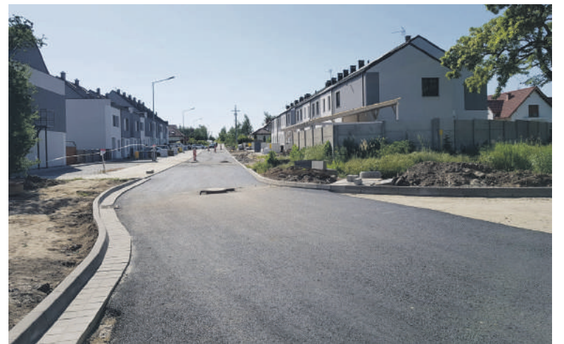
Trwają prace związane z budową drogi na ul. Tęczowej
