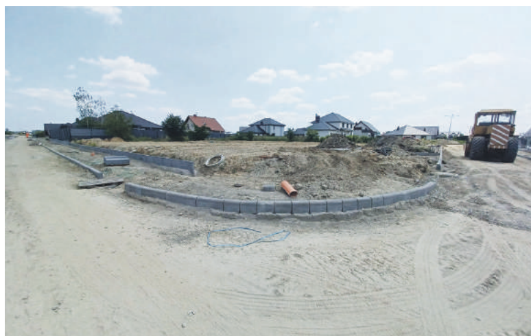
Widać pierwsze efekty robót związanych z budową dróg osiedlowych
