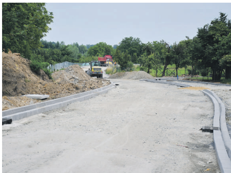
Ulice Kosynierów, Demokratów i Gliniana są w trakcie przebudowy
