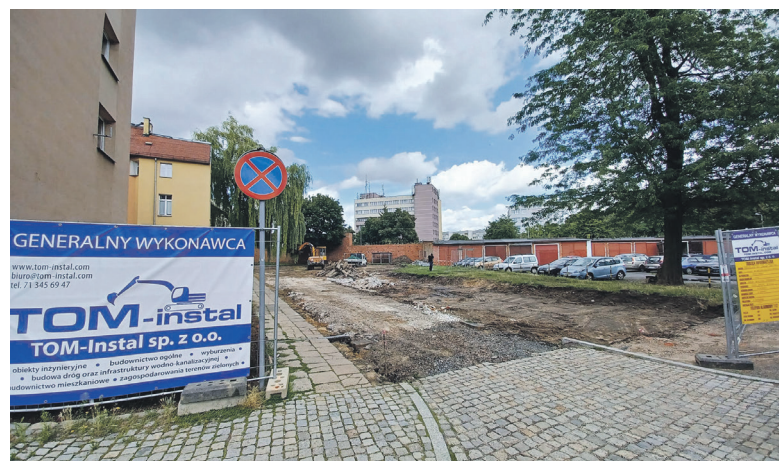
Trwa przebudowa terenu przy ul. Szkolnej i Matejki
