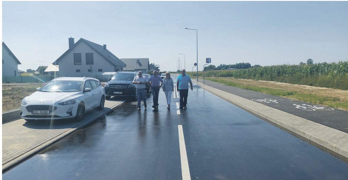
Ulica Belgijska ma już nową nawierzchnię. Mieszkańcy mogą komfortowo dojechać do swoich posesji
