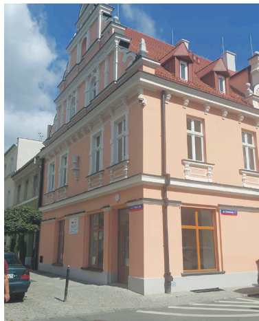
Prace związane z odbudową budynku rozpoczęły się w 2021 r.
