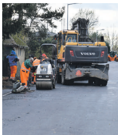
Prace przy ul. Mokrej realizowane są na odcinku od Jastrzębiej do Wiejskiej
