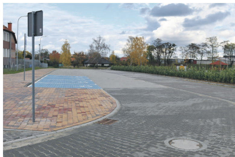
Przy Parku Południowym powstały nowe parkingi, chodnik i droga
