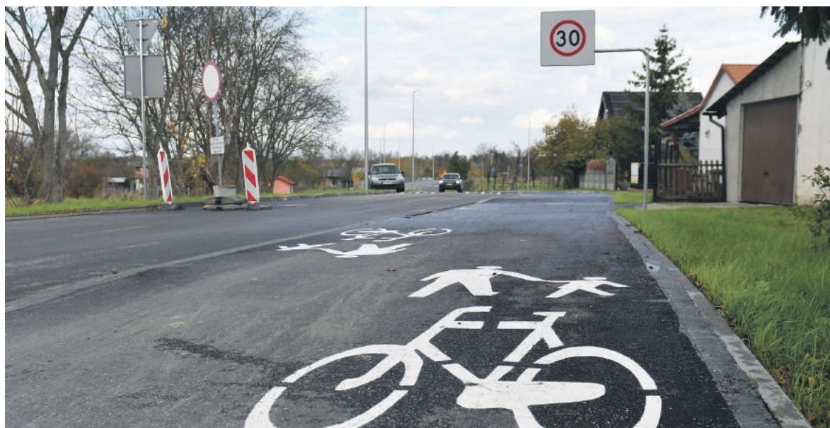
Prace przy ul. Kosynierów dobiegły już końca
