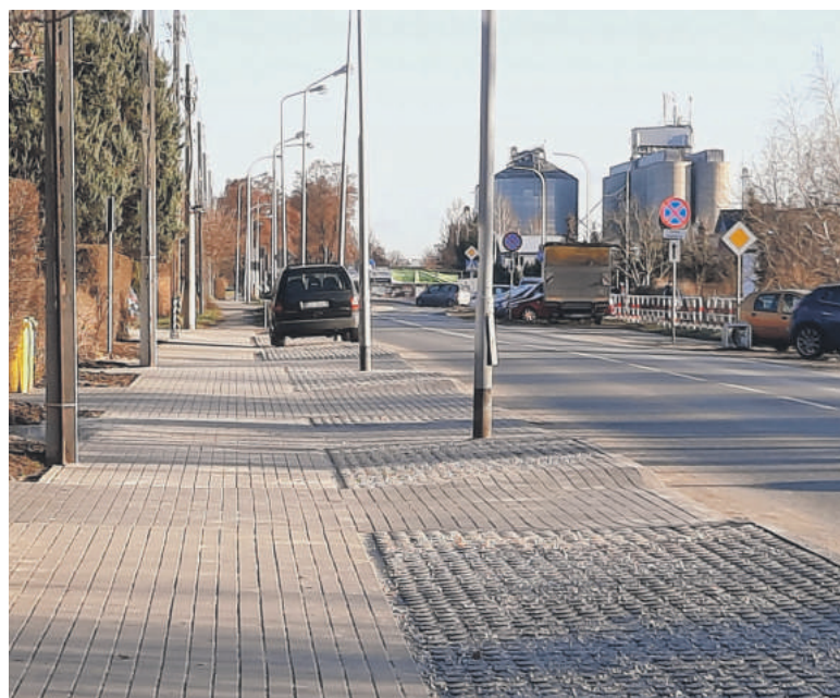
Zakończyła się przebudowa chodnika i zjazdów w ciągu ul. Krzywoustego
