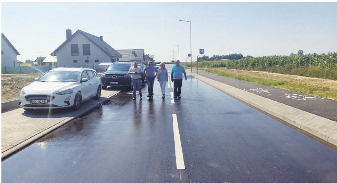
Ulica Belgijska ma nową nawierzchnię. Mieszkańcy mogą wygodnie i bezpiecznie dojechać do swoich posesji
