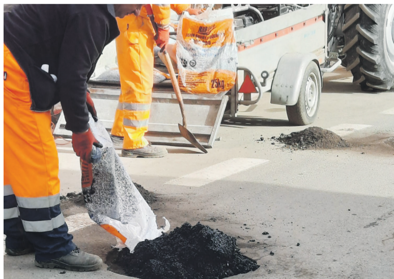
Drogowcy prowadzą naprawy konserwacyjne i remonty jezdni
