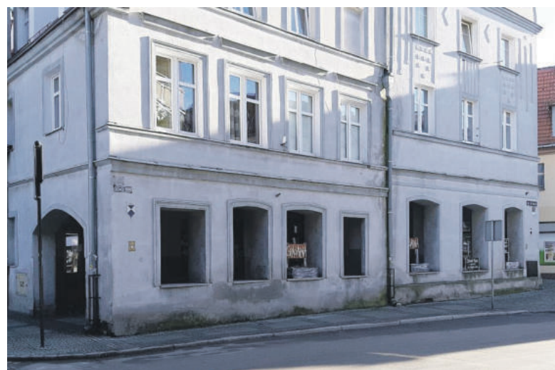
W przejściu i oknach pojawią się estetyczne i stylizowane kraty
