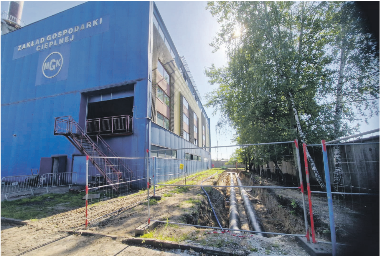
Remont magistralnej sieci kanałowej dn500 mm na sieć preizolowaną dn350 mm
