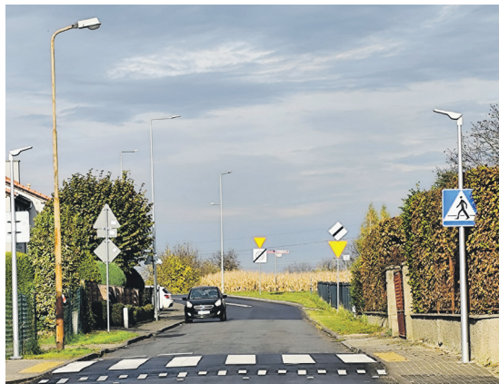
Ulica Trzebnicka - przebudowa drogi, wyniesione przejście dla pieszych w ul. Północnej
