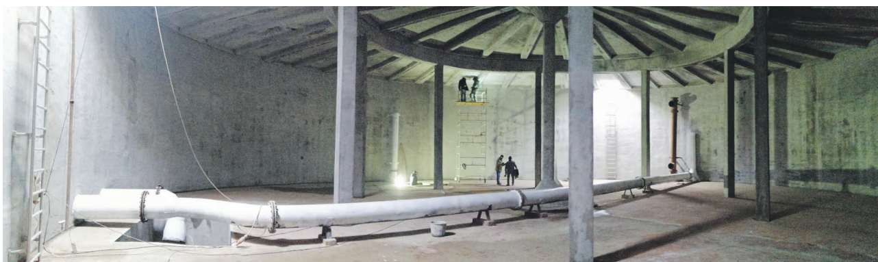
Modernizacja zbiorników wody czystej na terenie ZUW Dobroszycka.
