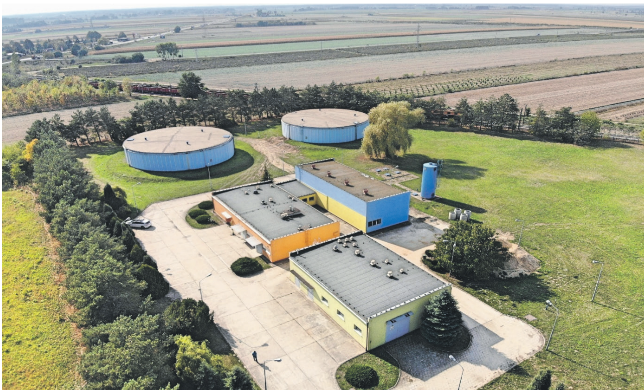
Zakład uzdatniania wody przy ul. Dobroszyckiej w Oleśnicy.
