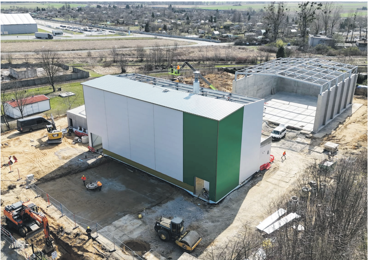
Budowa kotłowni biomasowej o mocy cieplnej 10 MW przy ul. Ciepłej w Oleśnicy.
