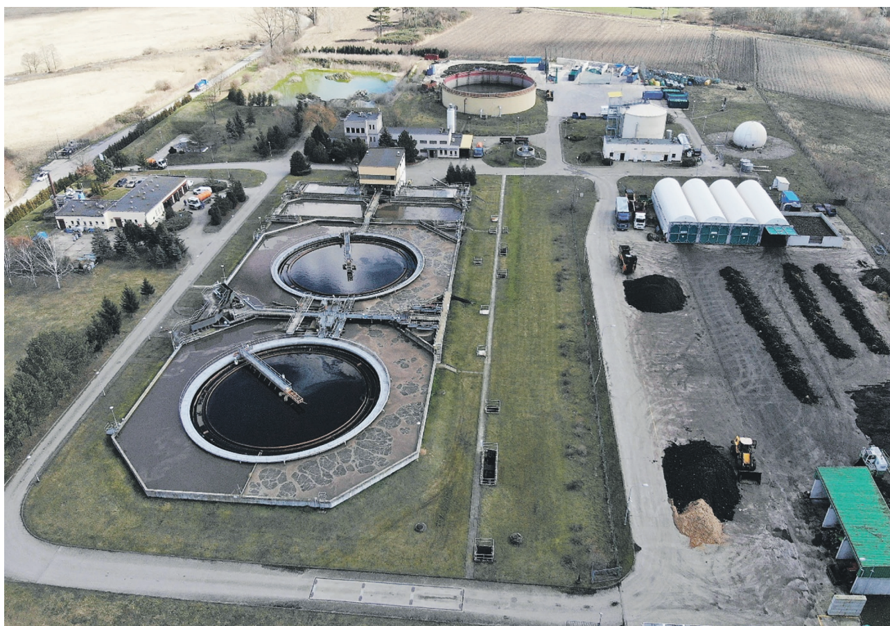
Oczyszczalnia ścieków wraz z kompostownią odpadów w Oleśnicy.
